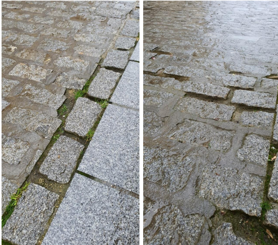
Detalles de situación de la pavimentación
